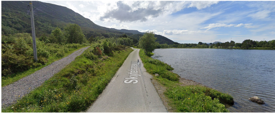
Figur 23: Skytebanevegen i midten, men Vassetvatnet til høyre og turvegen til venstre. Sett mot nordvest.
